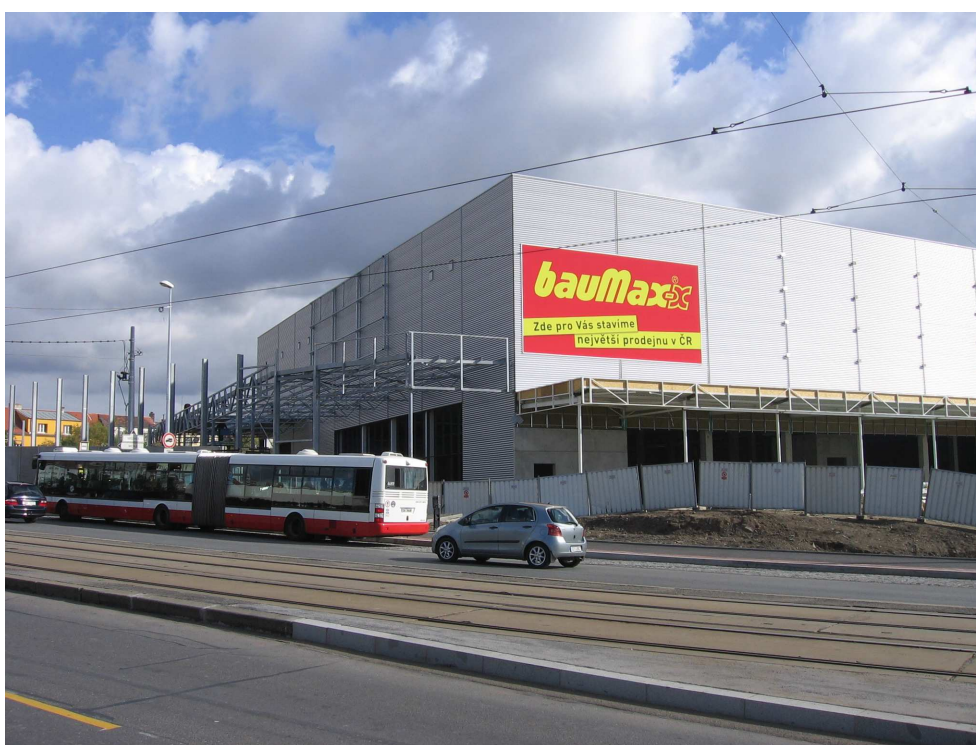
Výstavba prodejny bauMax
