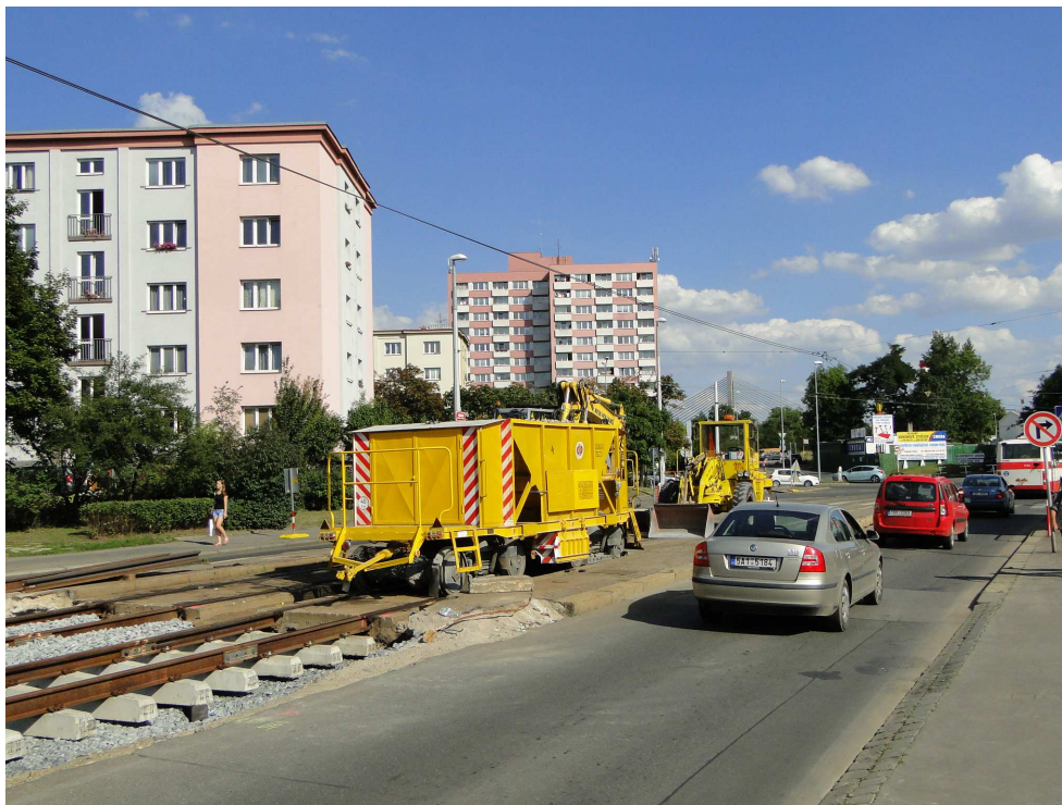
Oprava tratě u stanice Na Padesátém
