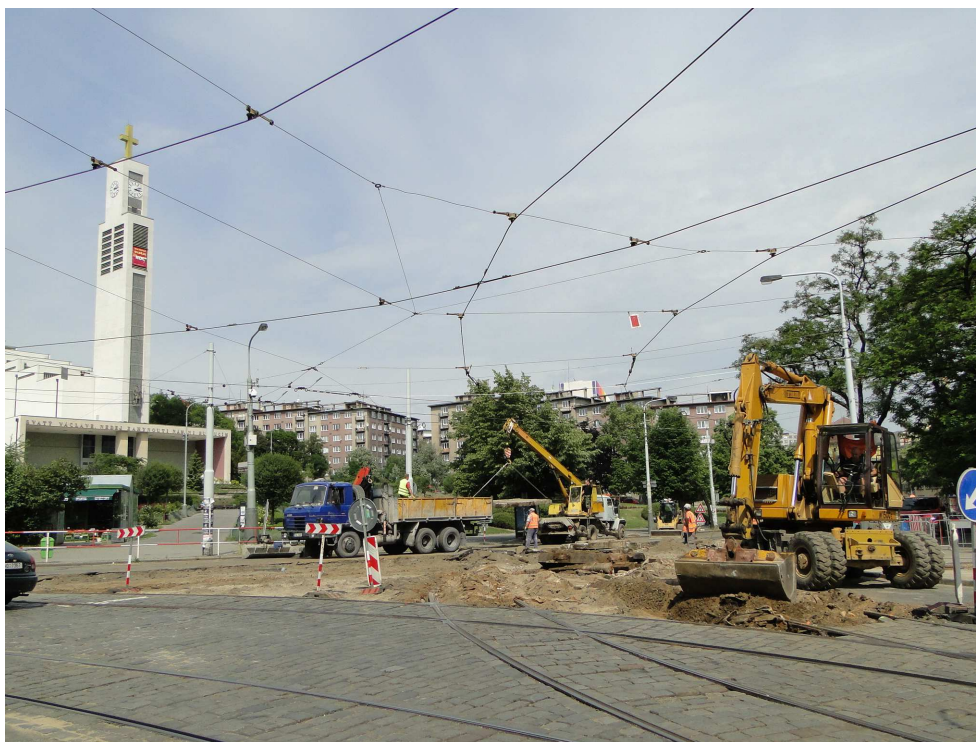
Rekonstrukce tramvajové trati na Čechově náměstí
