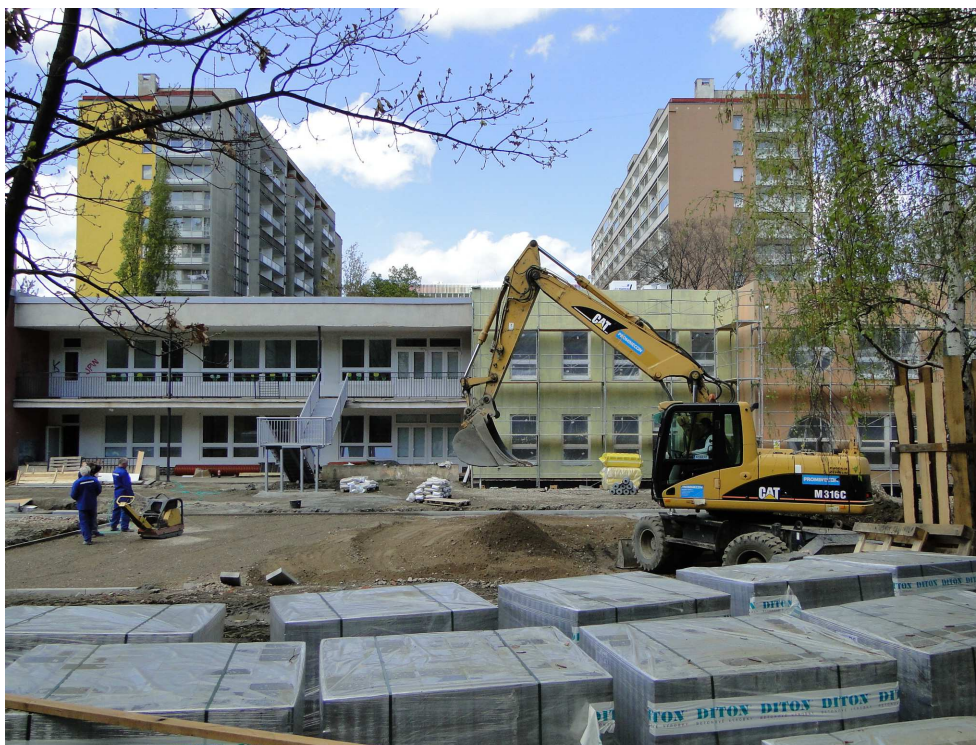
Výstavba MŠ Magnitogorská
