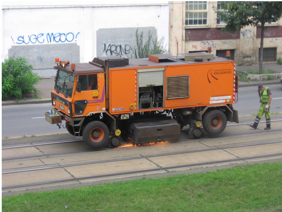
Práce na kolejích
